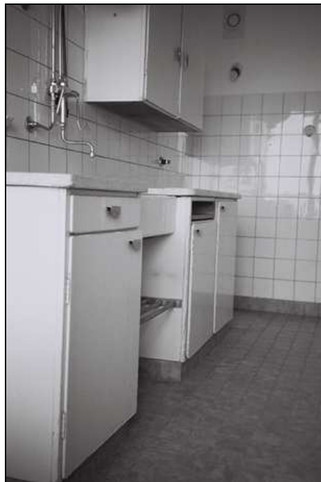
14 Originele keukenbetimmering van het fabriek Bruynzeel, type Monta-Z.
