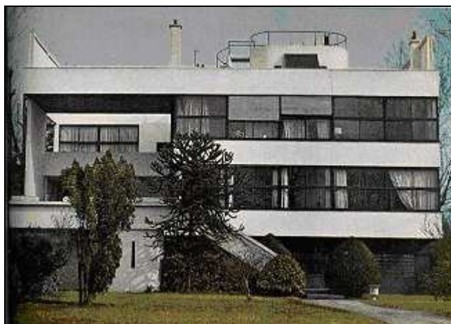
19 Les Terrasses, Vaucresson, Le Corbusier, 1926. Achterzijde van het huis wat uiterlijke overeenkomsten vertoont met de Panoramaflat.
