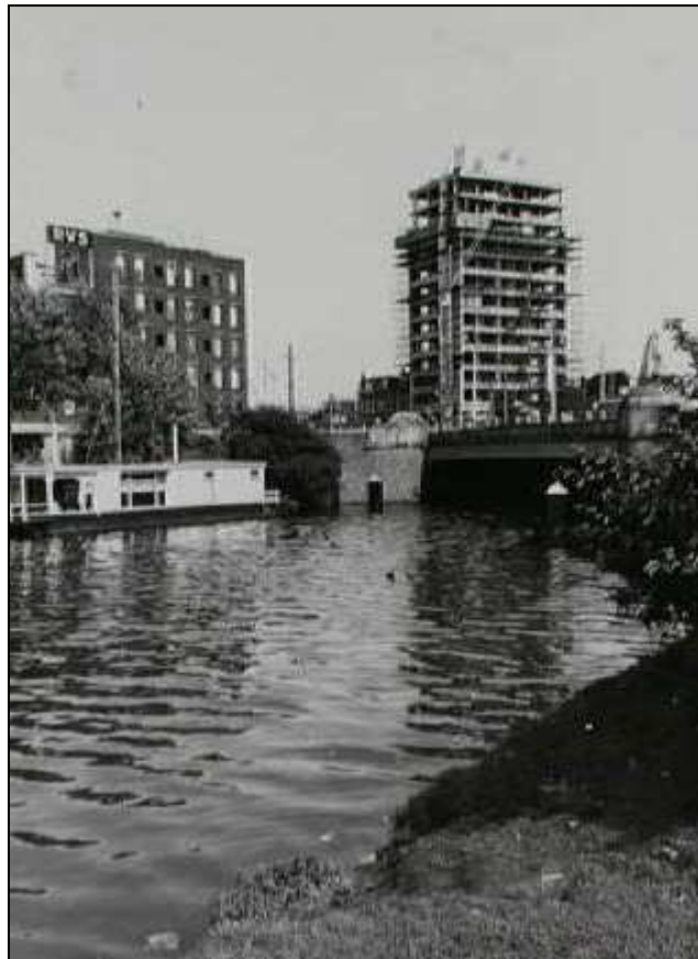
9 Panoramaflat in aanbouw gezien vanaf de Suezkade, augustus 1961.
